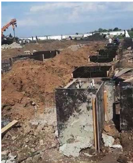
Так починався завод. Заливання фундаменту під опори
