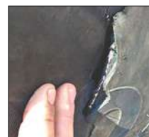
приклад бічного пошкодження
