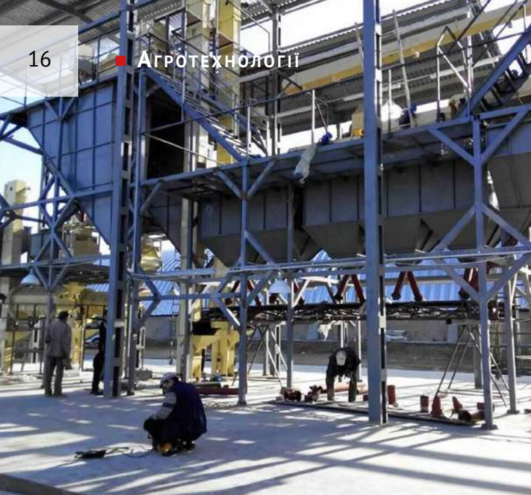
Рис. 3. Будівництво насіннєвого заводу ТОВ ВКФ «Агро-Еко ХХІ», Хмельницька обл.
