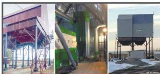
РЕКОНСТРУКЦІЯ, БУДІВНИЦТВО ЗАВ-ів ТА КЗС
