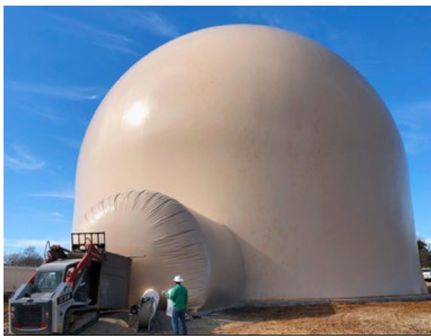
Сучасні складські приміщення мають еластичні стіни: це зменшує імовірність підвищення тиску до критичного рівня
