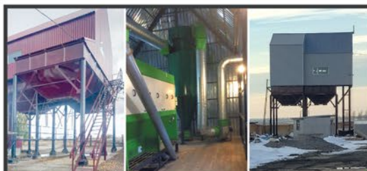
РЕКОНСТРУКЦІЯ, БУДІВНИЦТВО ЗАВІВ ТА КЗС
