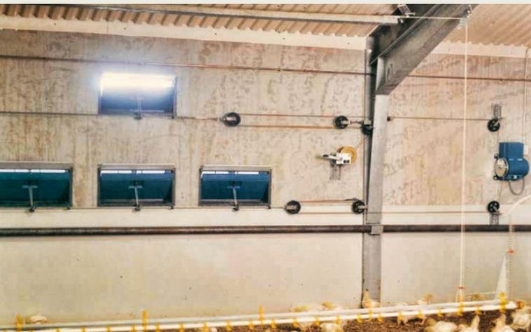
Рис. 8 Система механического дистанционного управления приточными форточками
