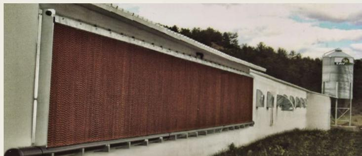
Рис. 12 Птичник с испарительными панелями
