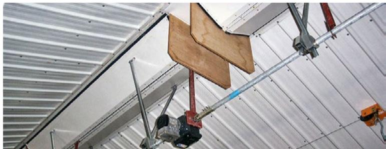
Рис. 3 Механический привод потолочных заслонок
