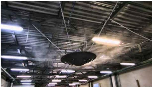
Рис. 9 Дискосвая система распылительного охлаждения
