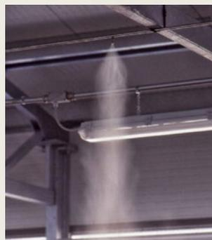
Рис. 11 Форсуночная система охлаждения
